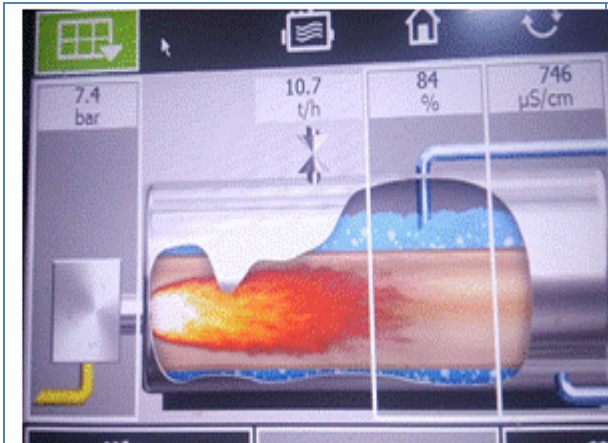
Boiler operating parameter
